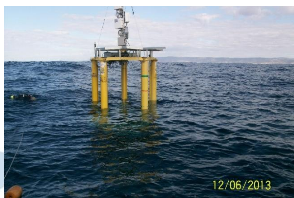
Fig. 10.- Instalando bidones para flotación.
