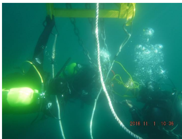
Figura 8.- Buzos colocando la cadena de fondeo en la parte inferior de la BOC2.
