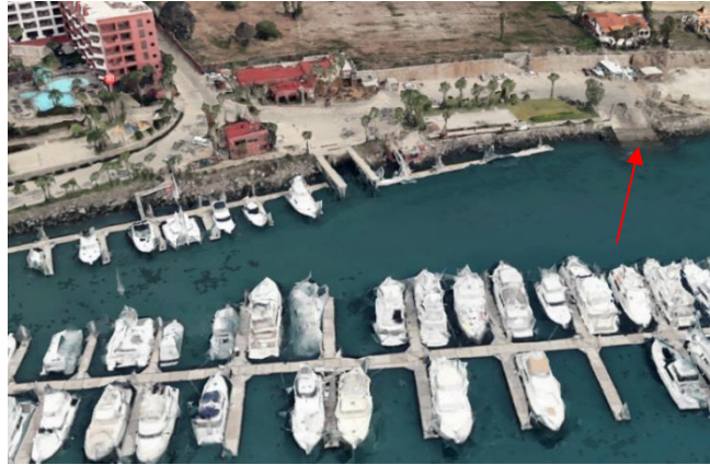
Fig. 1.- Rampa de la marina Hotel Coral.
