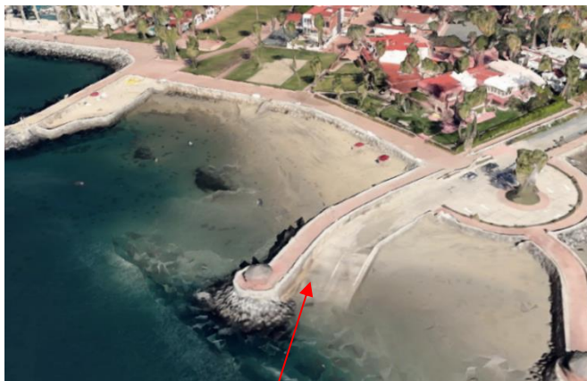
Fig. 3.- Rampa de acceso al Estero de Punta Banda.
