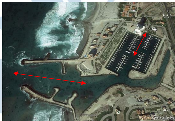
Fig. 2.- Rampa de la marina del Hotel Puerto Salina.
