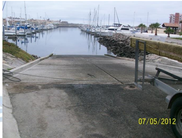
Fig. 4. Rampa Marina Puerto Salina.
