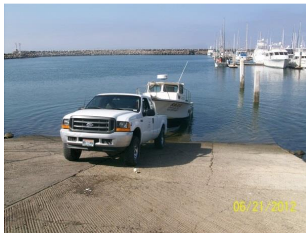
Fig. 3. Rampa del HC&M.
