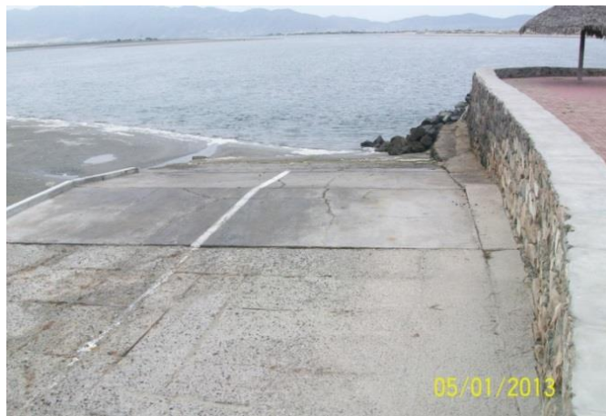
Fig.5. Rampa del Hotel Estero Beach .
