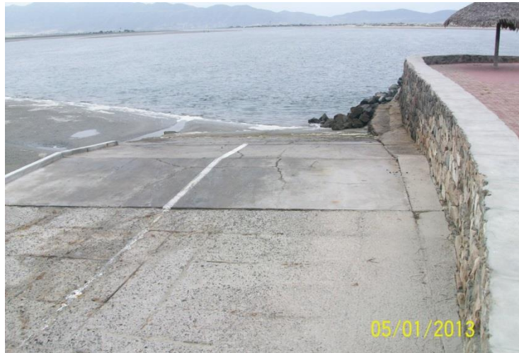
Fig.5. Rampa del Hotel Estero Beach.
