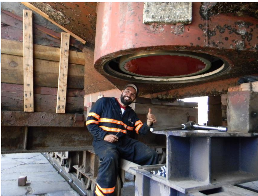
Figura. 5.- Transductor del ADCP montado en su nicho, sin ventana acústica.
